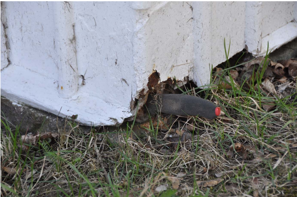
Liksom här där hela bladet på en morakniv lätt skjuts in i virket.
